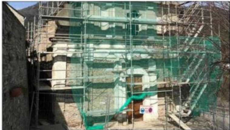
Les échafaudages qui permettent de travailler sur les façades sont en place pour longtemps.
