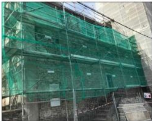
La pierre a été mise à nu en vue de refaire un crépi à la chaux à l'ancienne.
